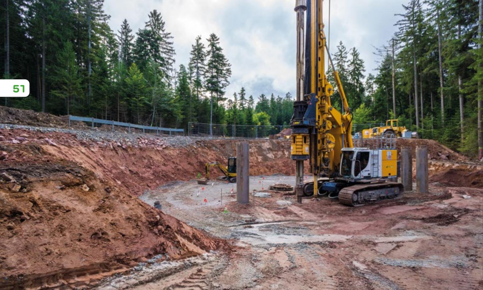
Gewaltige Beton-Fundamente, rund 15 m tief, müssen für diese Anlagen in die Erde getrieben werden
